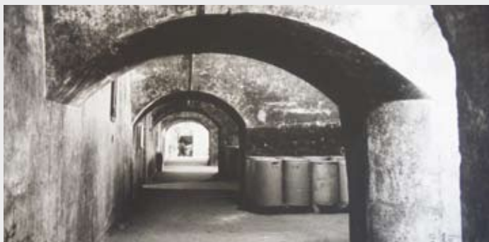
Tinghøjbatteriets strubekaserner var konstrueret i en etage, ca. 6 m høj med bastionært grundrids i struben. Ud til kasematgangen var indrettet fire større mandskasematter samt køkken, depotrum og ammunitionsmagasin. Foto 1980.
