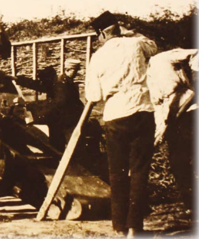
Buddinge-batteriets 12 cm jernkanoner er taget ud af skytsmagasinet, og "bakses" nu på plads på cementbriksene (underlagene) bag hovedvolden. Til højre ses en risbeklædt travers. Foran denne og på brystværnet ses soldater med lyse huer og bukser, det er fodfolk, der hjælper artilleristerne (i drejlsbluser) med de mange klagøringsarbejder. Foto 1914.
